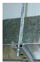
Крепление воздуховодов при помощи траверсы и шпильки
