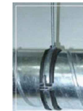
Крепление при помощи хомута и шпильки
